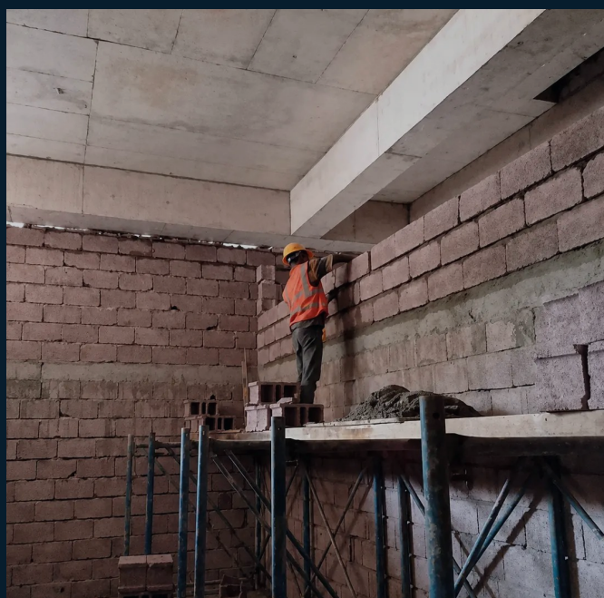
Guestroom masonry / Maçonnerie des chambres
