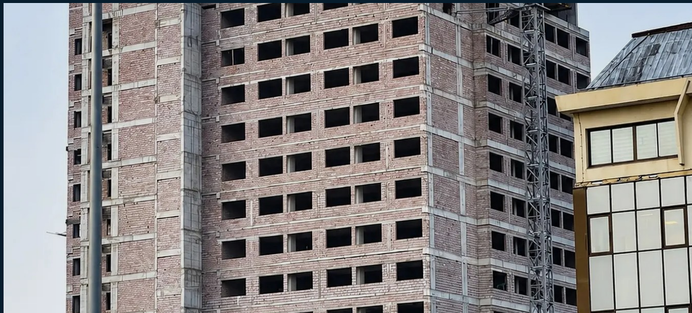
Exterior construction / Construction extérieure
