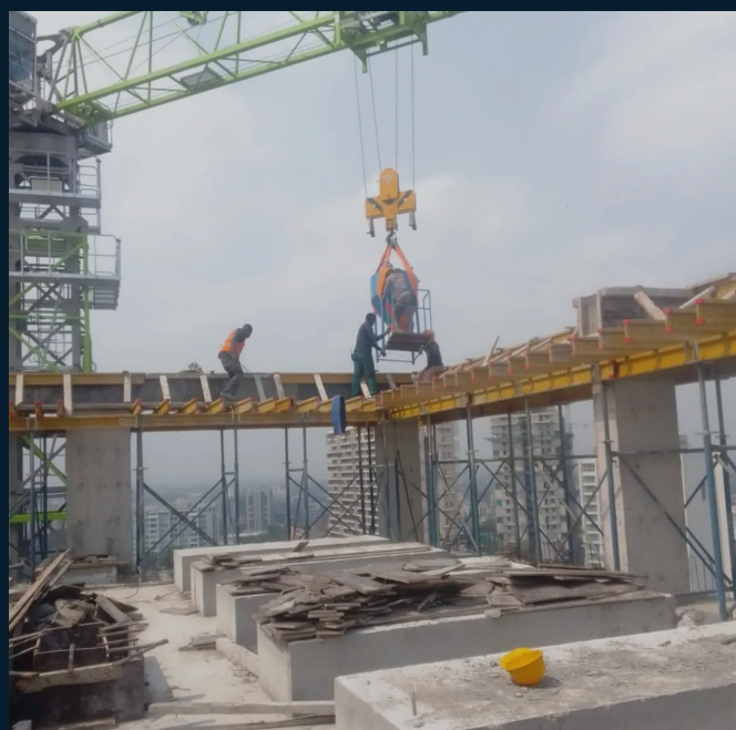
Rooftop works / Travaux en toiture
