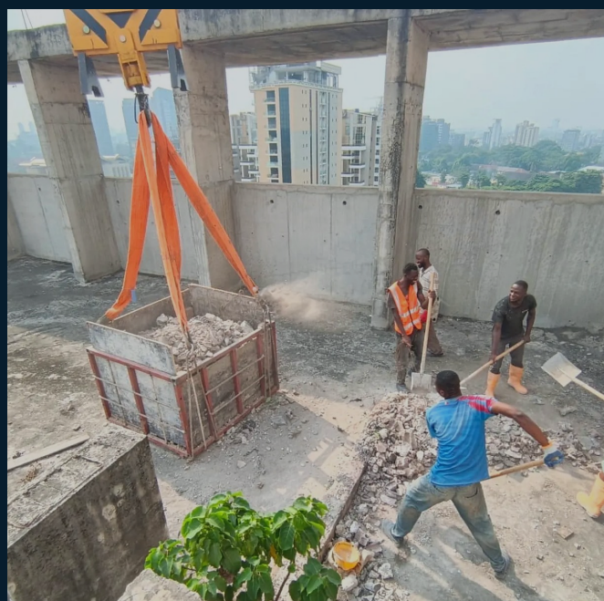
Site works / Travaux sur site
